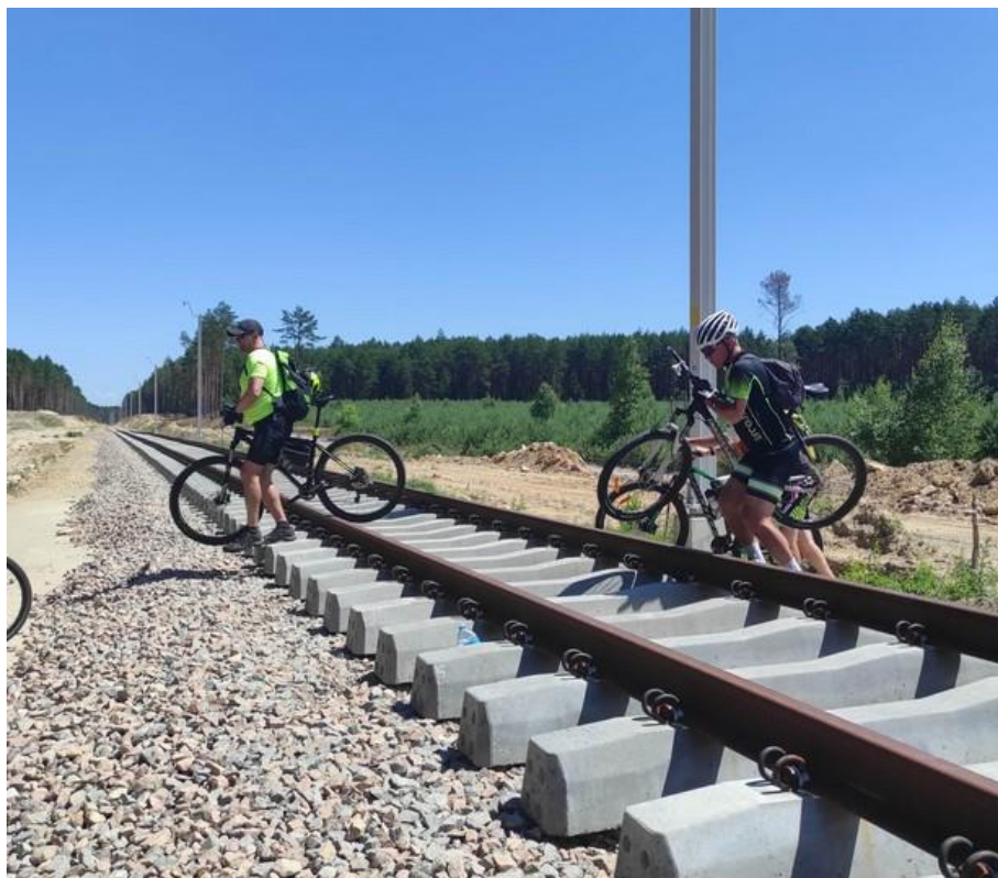
Nowa trasa kolejowa do lotniska w Pyrzowicach.
