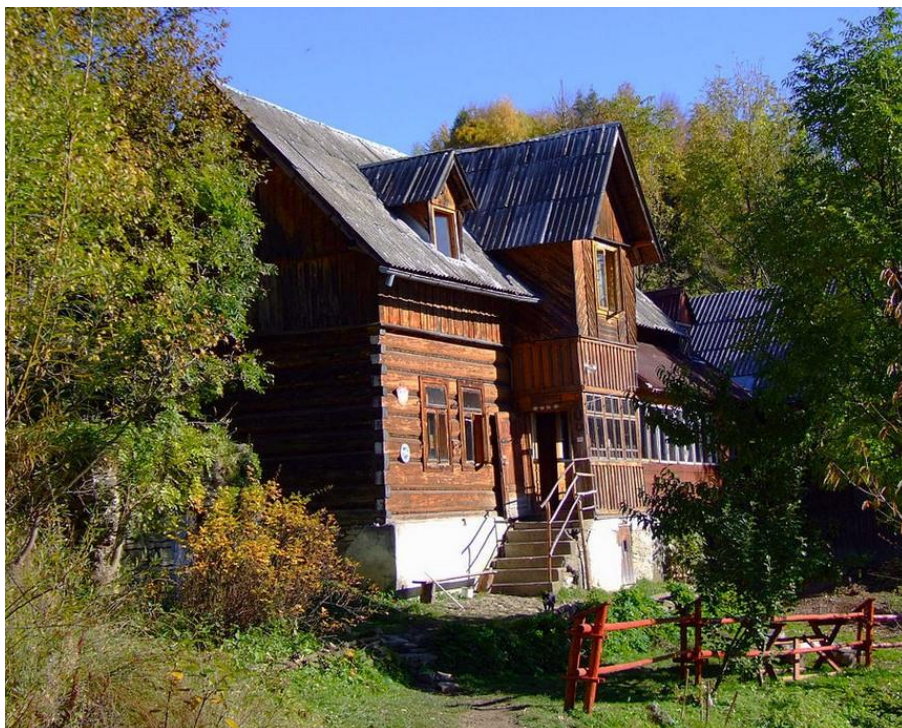
Widok obiektu przed pożarem
