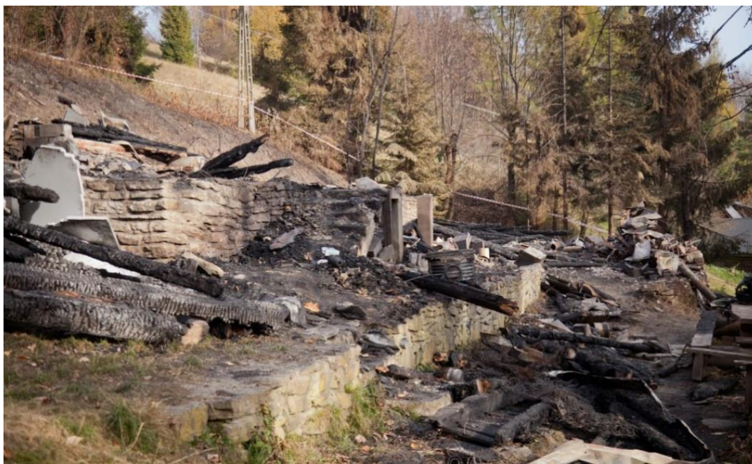
Zgliszczka pozostałe po pożarze
