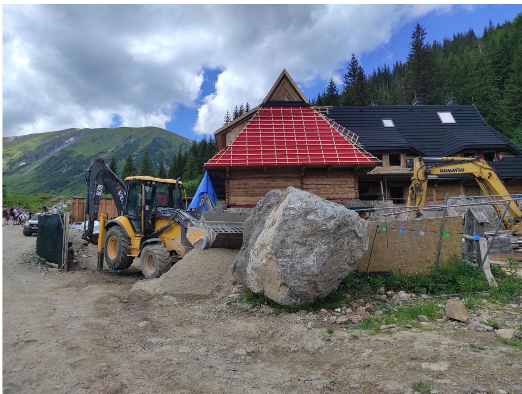
Budowa schroniska w Kondratowej (zakończenie budowy planowane w maju 2025 roku).
