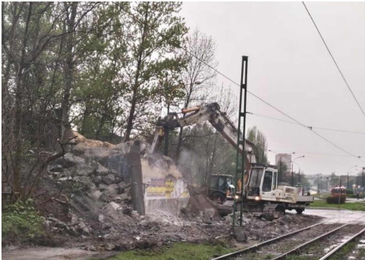
Rozbiórka wiaduktu nad ulicą gen. Andersa (marzec 2016 r.)
