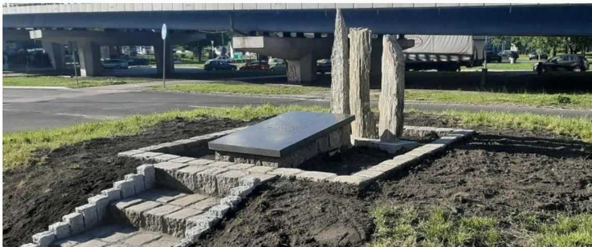
Stan po ponownym zamontowaniu płyty i posadowieniu głązów szpilkowych
