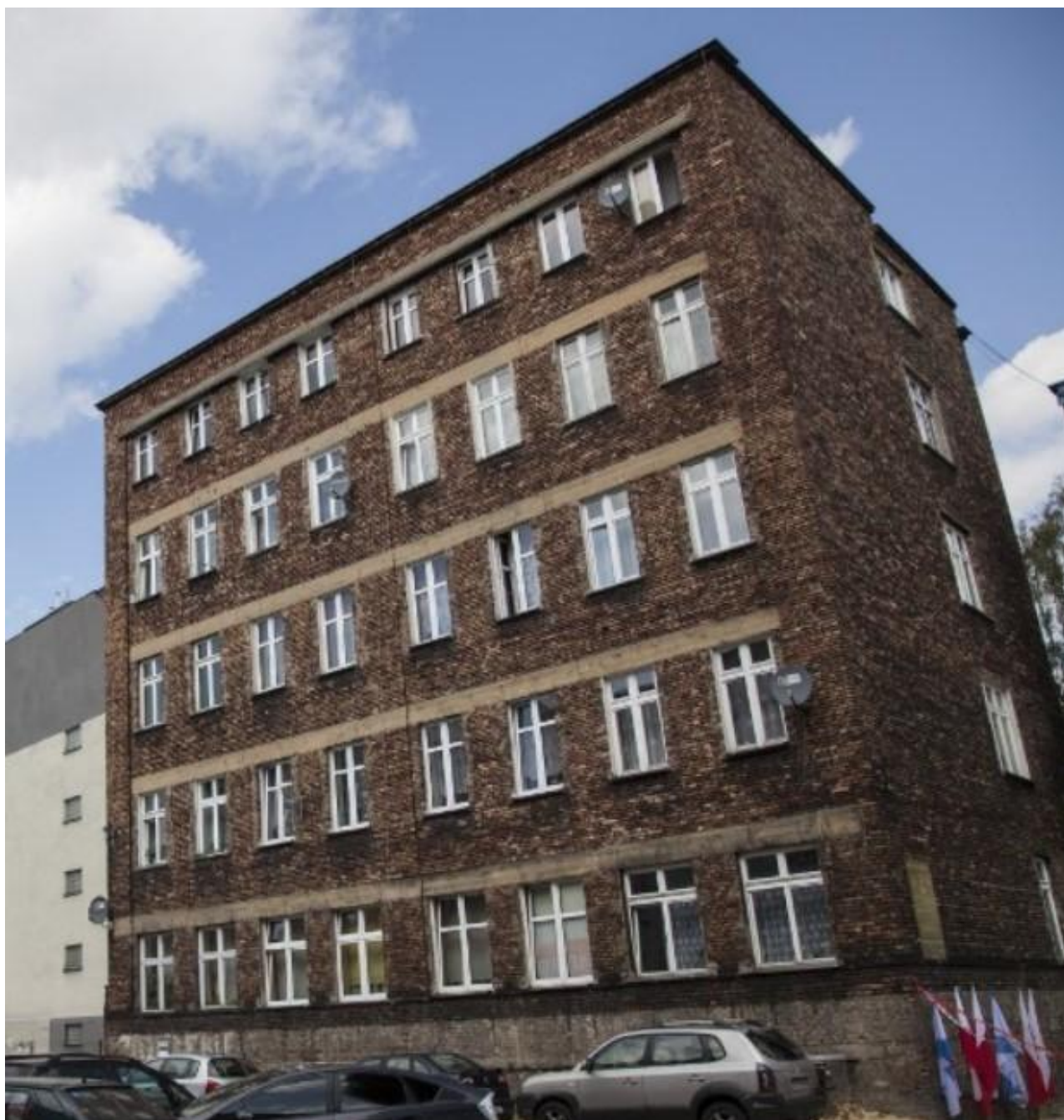
Budynek przy ul. Ostrogórskiej 5a w Sosnowcu w miejscu dawnego więzienia
