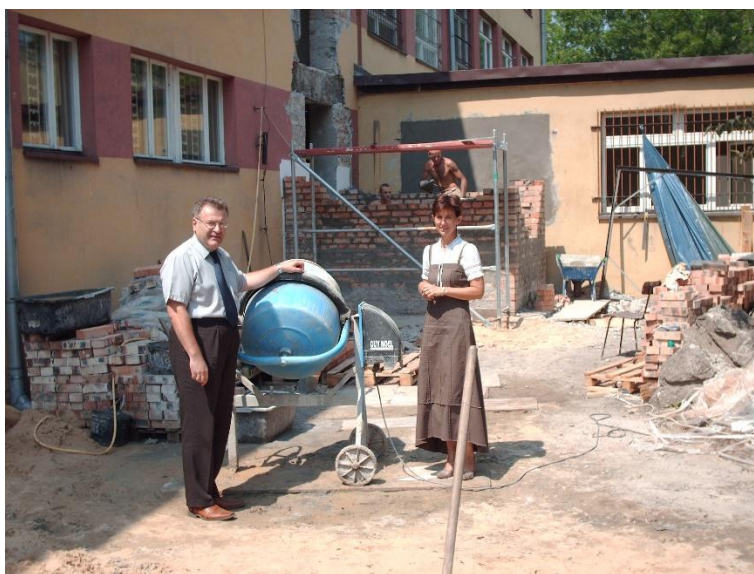
Modernizacja budynku na potrzeby Zespołu Szkół Specjalnych Nr 4 w Sosnowcu
